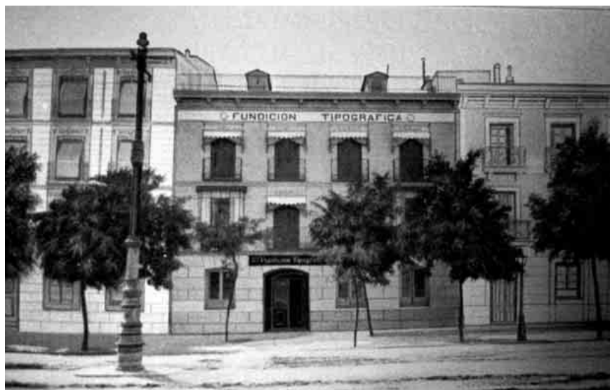
Fachada de la calle Princesa, 63 (1911). ▶
