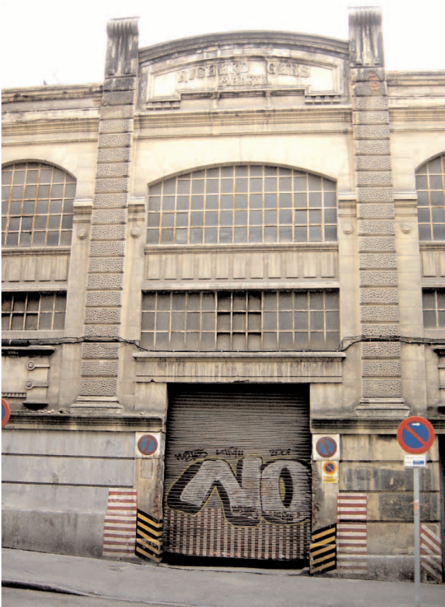
▲ Estado actual de la fachada en la calle Altamirano, 3.
